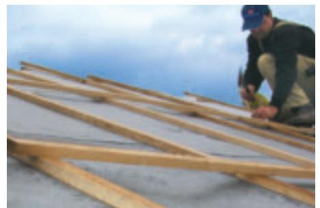
Über der Unterspannbahn wird die Lattung angebracht. (URSA)
