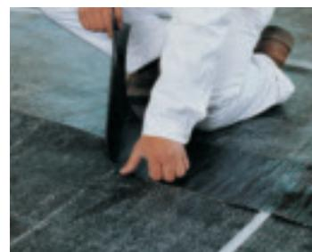
Gegen aufsteigende Feuchtigkeit – Knauf Abdichtungsbahn Katja Sprint. (Knauf)
