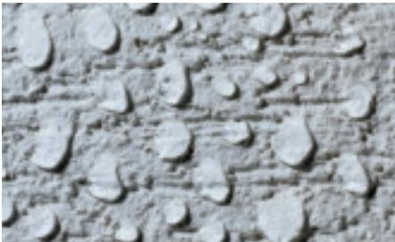
Putzfassade mit Wetterschutz-Imprägnierung. (PCI)
