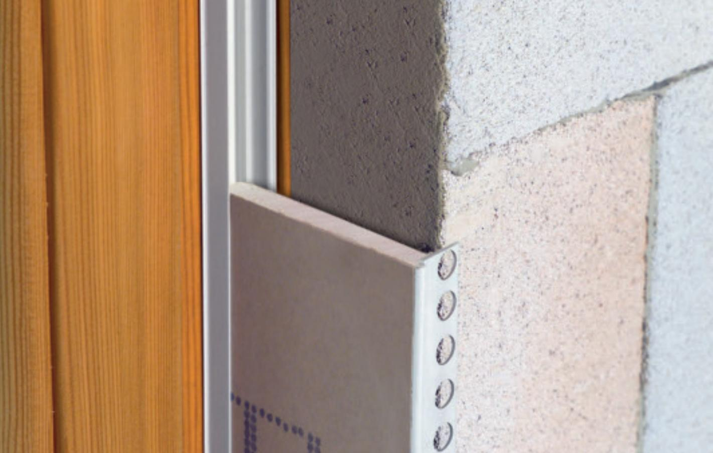
Laibungsprofil für perfekten Anschluss. (PROTEKTORWERK)
