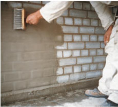
Rissgefährdete, erdberührte Wände lassen sich mit Dichtschlämme zuverlässig versiegeln. (Ceresit)
