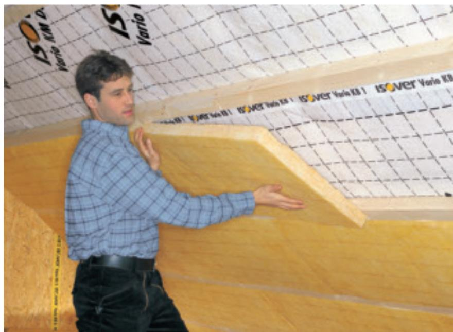
Wärmebrücken reduzieren mit Integra UKF 1 und UKF 2 (Saint-Gobain Isover)
