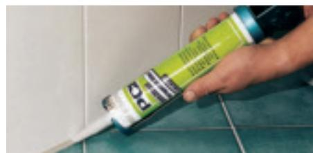
Anschlussfugen müssen dauerelastisch mit einem hochdehnfähigen Silikon-Dichtstoff abgedichtet werden. (PCI)
