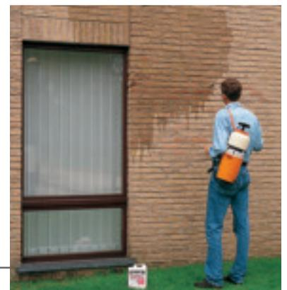
Imprägnieren: Aufsprühen und die Poren werden verschlossen. (Ceresit)
