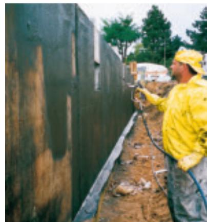
Superflex 100 S ist die sprühbare Variante für den noch komfortableren Einsatz. (DEITERMANN)
