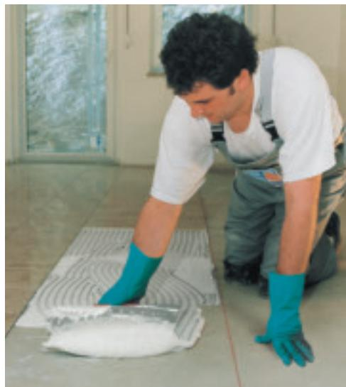
Einfache Verlegung im Dünnbettverfahren bei ebenen Untergründen. (PCI)
