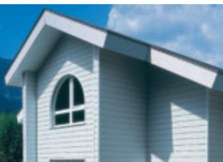
Fassadenprofil Siding: 78 Farben sind möglich. (Werzalit)
