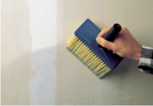
Sopro Grundierung wird vollsatt aufgetragen. (Sopro)
