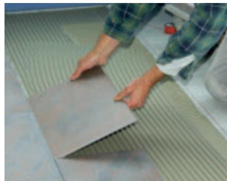
Einsetzbar als Fließbettmörtel und auch als herkömmlicher ausreichend standfester Dünnbettmörtel – PCI Nanoflott® flex. (PCI)
