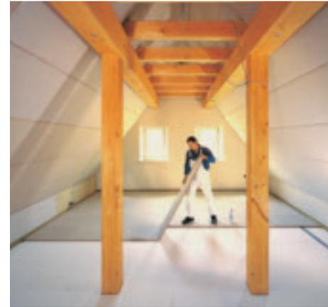
Für festen Boden unter den Füßen – Trockenstrichelemente: Bei ebenem Untergrund direkt auf dem Rohboden verlegbar. (Knauf)
