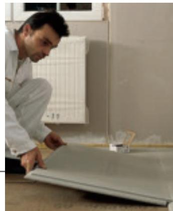
AQUAPANEL® – der trockene Estrich. (Knauf Perlite)
