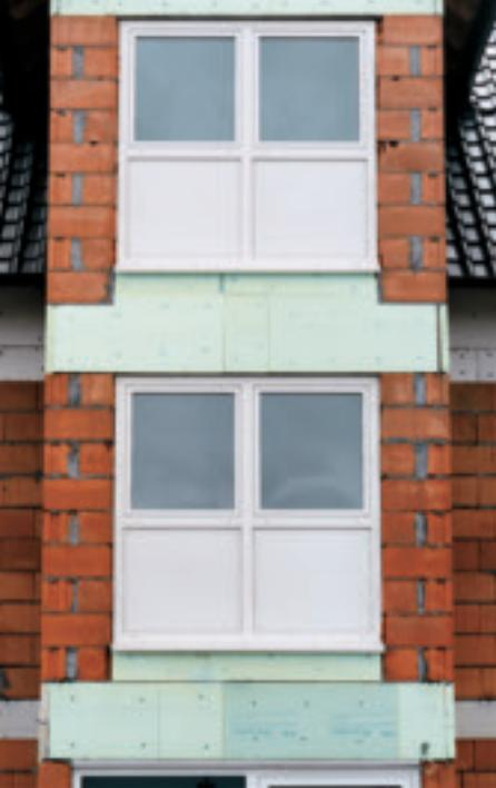
Dämmung zur Vermeidung von Wärmebrücken in der Gebäude-Außenwand. (Saint-Gobain Isover)
