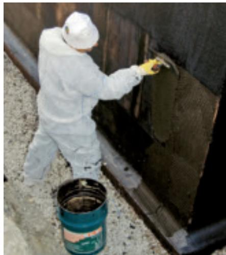
Geschmeidig-leicht durch Polystyrolfüllung – Kelleraußenwandabdichtung mit PCI Pecimor® Super. (PCI)
