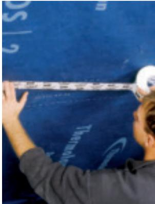
Die Dampfbremse Thermolan LDS 2 wird mit dem Klebeband Soliplan verklebt und abgedichtet. (Knauf Insulation)
