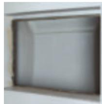
Rahmen aus Winkel- oder T-Eisen bleibt im Mauerwerk
