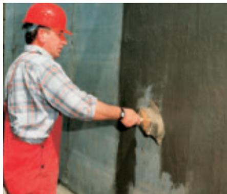
Plastisch-geschmeidig – Poren und Vertiefungen werden leicht und schnell geschlossen mit PCI Dichtschlämme. (PCI)
