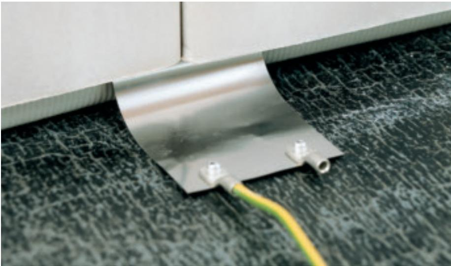
Knauf Schutzplatte LaVita. Die Strahlung wird abgeleitet. (Knauf)
