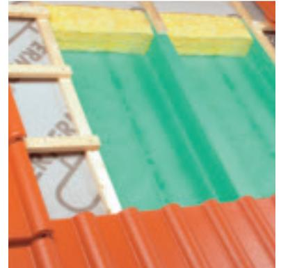
Wallint® 3 lässt aufatmen: Die diffusionsoffene Luftsperrbahn ist ideal bei Dach-Sanierungen. (Klöber)
