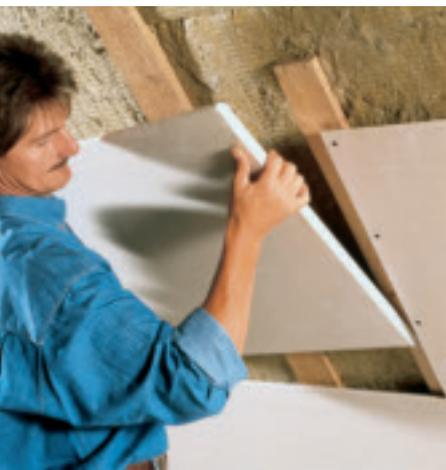
Die Knauf Paneelplatte ist besonders stabil, deshalb lässt sie sich Material sparend mit „fliegenden Stößen“ montieren. (Knauf)
