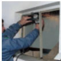
Fenster aushängen, evtl. Mittelsteg entfernen
