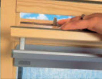
Durch den Sicherungsriegel kann der Fensterflügel sturm- und kindersicher arretiert werden. (VELUX)
