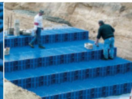
**Durchdachtes Zubehör, Steck- und Sicherungselemente garantieren ein Höchstmaß an Verwindungssteifigkeit. Ganz rechts: Projektbeispiel VW-Braunschweig. (Wavin)**
