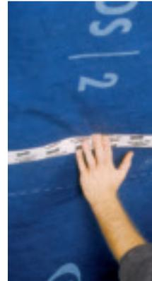
Nach Abziehen der Schutzfolie kann die Dampfbremse sofort auf der Kleberaube festgedrückt werden. (Knauf Insulation)
