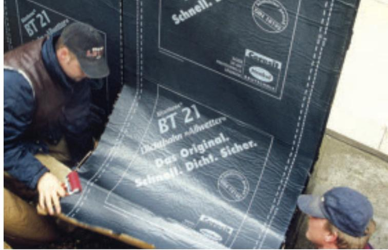
Einfach an das vorhandene Mauerwerk anlegen: die BT 21 Dichtbahn „Allwetter“. (Ceresit)
