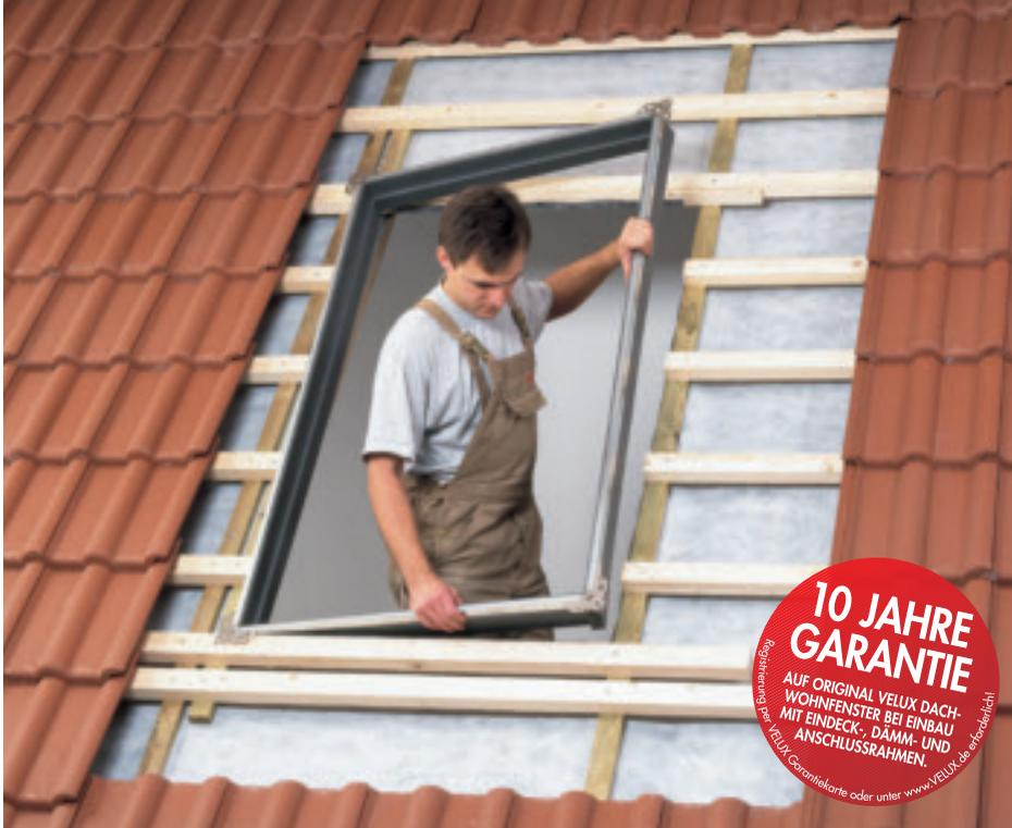
Die auf VELUX Fenster abgestimmte Montagetechnik schafft eine optimale Anbindung an das Dach. (VELUX)
