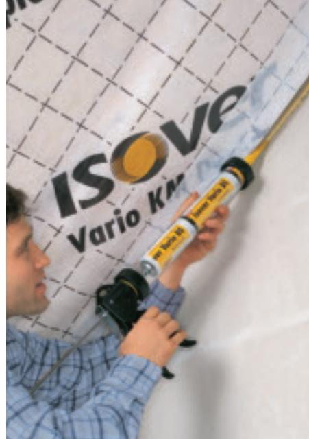
So wird es richtig dicht: mit dem Dichtstoff Vario DS. (Saint-Gobain Isover)
