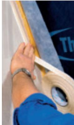
Von der Rolle wird die Kleberaube ohne Anpresslatte direkt auf Stein, Beton, Putz, Holz oder Metall geklebt. (Knauf Insulation)
