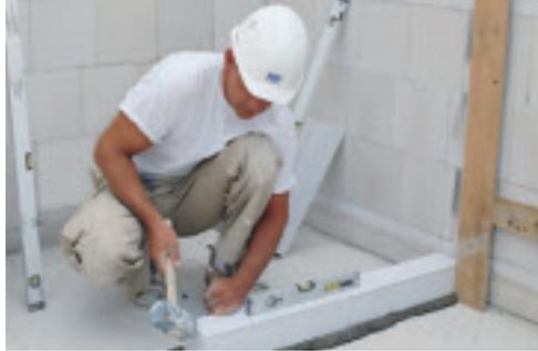
. . . zum Ausgleich von Unebenheiten der Bodenplatte. (SILKA)
