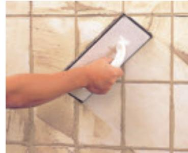
Fugenmasse diagonal zum Fugenverlauf einschlämmen. (Sopro)
