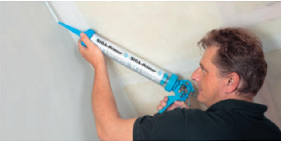
Anschlüsse von Dampfbremsen an verputztes Mauerwerk werden mit SIGA-Primur luftdicht verklebt. (SIGA)
