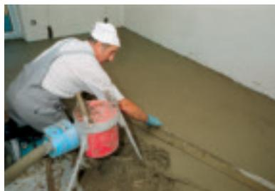
Bereits begehbar nach 3 Stunden, nach einem Tag belegbar – PCI Novoment®Z1. (PCI)
