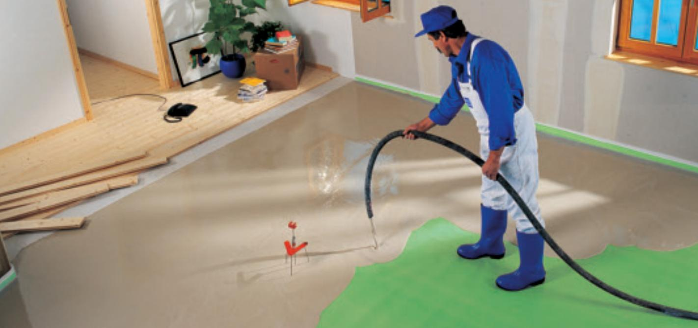
Knauf Fließestriche sind schnell eingebracht und nivellieren sich nahezu von selbst. (Knauf)
