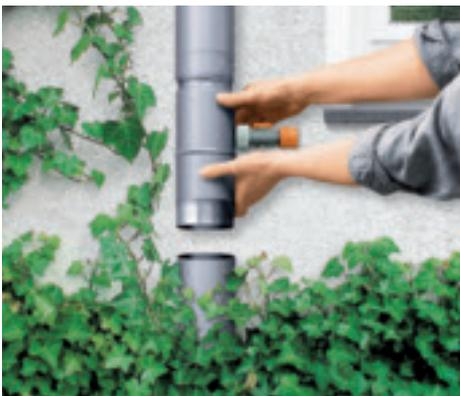
Nach Heraussägen eines ca. 30 cm langen Fallrohrstücks wird der RHEINZINK®-Regensammler einfach eingesetzt. (RHEINZINK)
