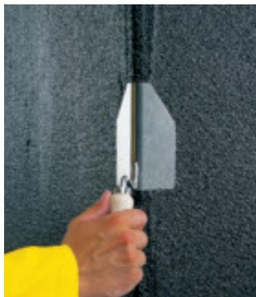
Herstellung einer Außenecke mit Außeneckenkelle. (DEITERMANN)
