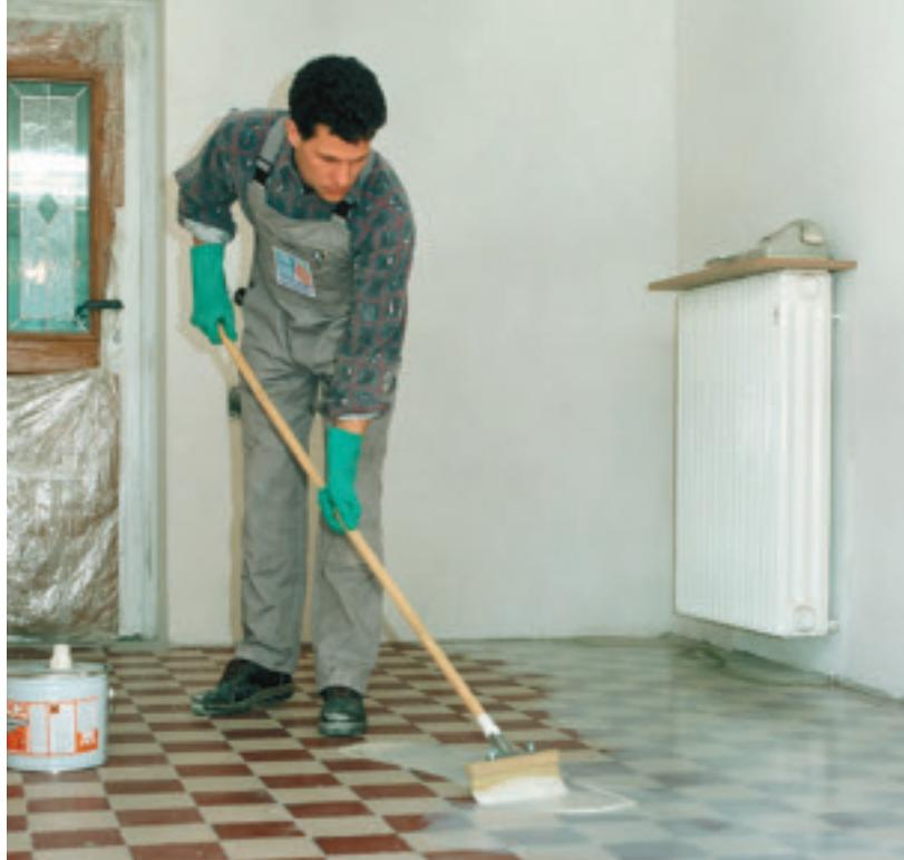
Fugenmasse wird mit dem Fuggummi oder Fugbrett diagonal eingeschlämmt. (PCI)
