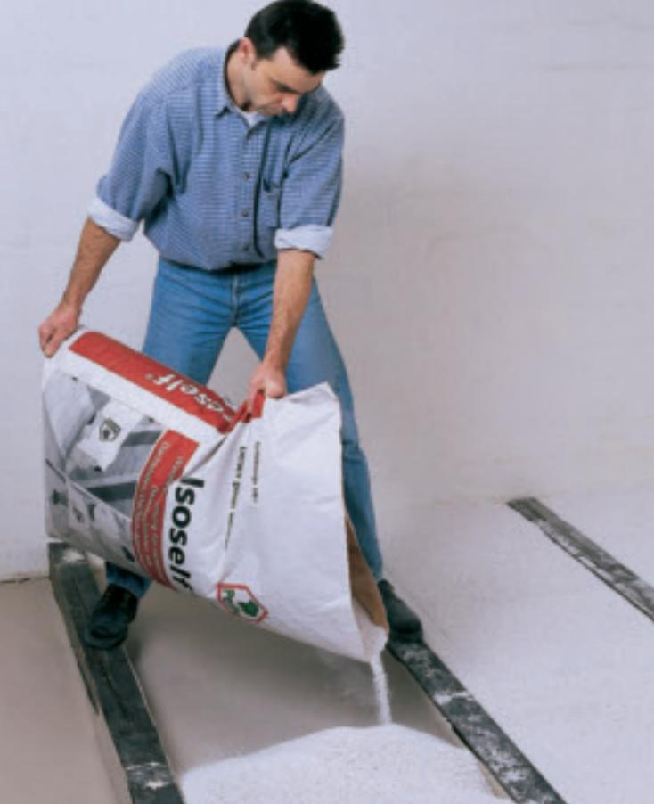
Isoself® – geschüttete Wärmedämmung. (Knauf Perlite)
