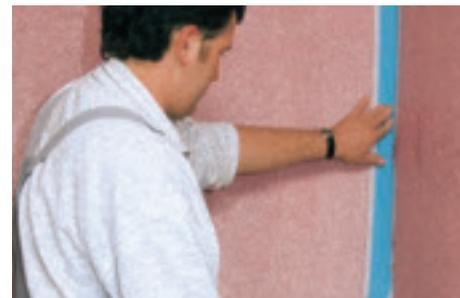
Eingebettet in die frische Abdichtungsmaterial-Auftragsschicht – PCI Pecitape®. (PCI)
