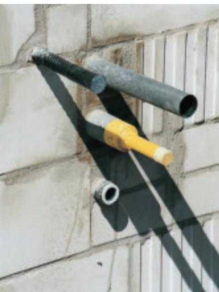
Leerrohre für Strom, Gas, Wasser und Telefon erleichtern den Hausanschluss. (Löwen)
