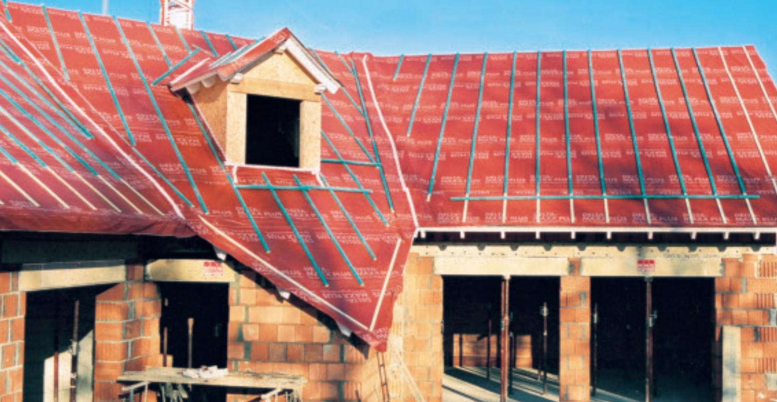
Die diffusionsoffene Unterspannbahn wird direkt auf einer Wärmedämmung oder Schalung verlegt. (DÖRKEN)
