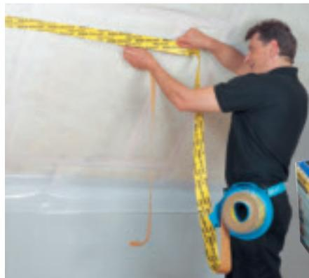
Überlappungen werden mit SIGA-Sicrall direkt von der Rolle überklebt – in einem Arbeitsgang. (SIGA)
