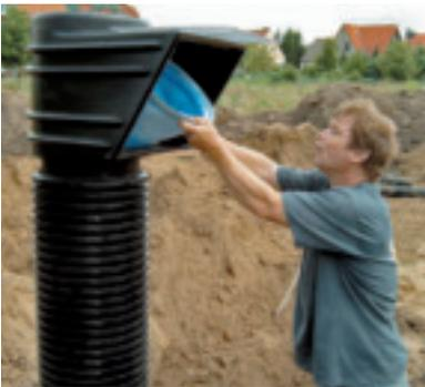
Einsatz des G 4-Filters: Der Keimeintrag wird deutlich reduziert. (FRÄNKISCHE)
