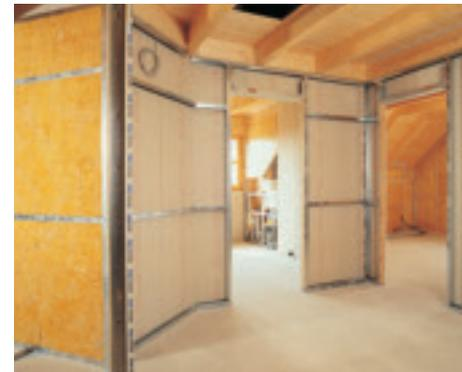
**Gestaltete Freiräume durch Trockenbau-Trennwände, hier mit Metall-Ständerwerk. (Knauf)**
