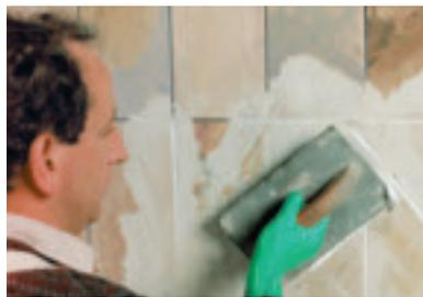
Verfugen von Marmor und edlen Naturwerksteinplatten mit quarzsandfreien Fugenfüllern. (PCI)
