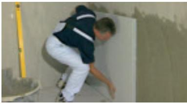
Die Platte wird angeklebt. (CALSIHERM)
