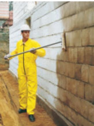
Eine Grundierung wird mit Wasser verdünnt aufgetragen. (DEITERMANN)
