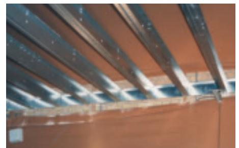
Trockenbau in neuer Dimension: Tragende Weitspannträger-Konstruktionen. (PROTEKTORWERK)
