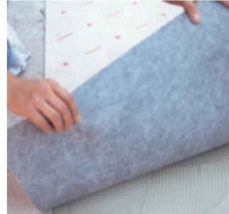
Verklebung der ADF®-Balkonfolie mit ADF®-Systemkleber. (SCHOMBURG)
