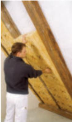
Die Zwischensparrendämmung Thermolan wird zwischen die Sparren geklemmt. (Knauf Insulation)
