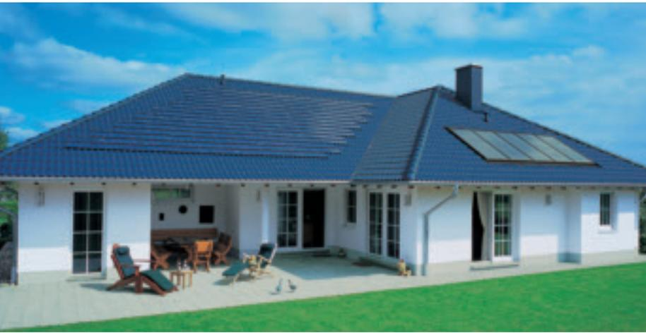
Solarstrom-System Photovoltaik und Solarwärme-System Thermokollektor. (BRAAS)
