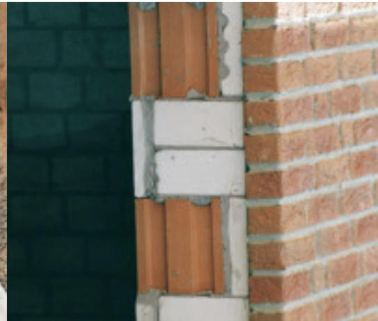
So nicht! Mischmauerwerk führt später zu SpannungsrisSEN. (Friemann)
