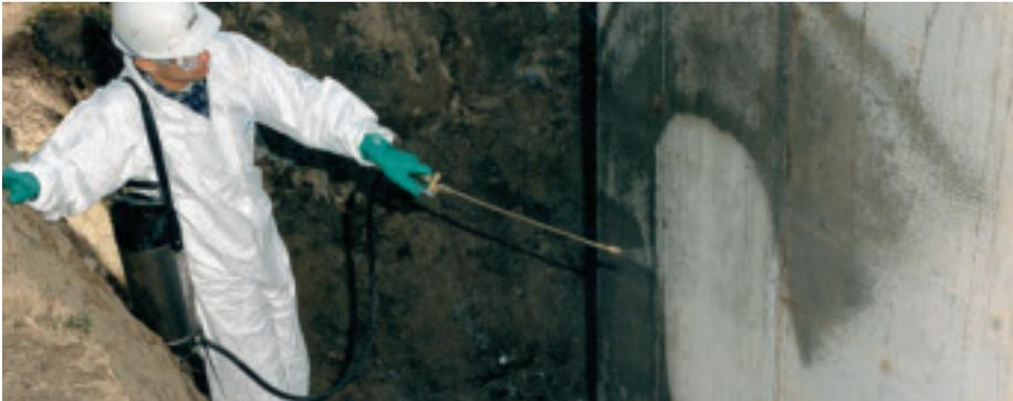
Blasenfreie Abdichtung mit Bitumen-Dickbeschichtung, nach Abdichtung mit PCI-Pecimor®-Betongrund. (PCI)
