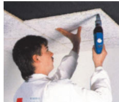
Schraubmontage – gedübelt. (AMF Deckensysteme)
