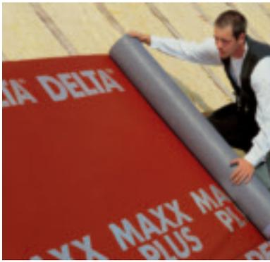
DELTA-MAXX PLUS wird mit Überlappung von unten nach oben verlegt. (DÖRKEN)
