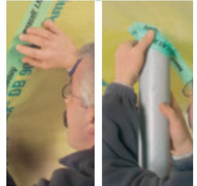
Ampacoll® I.N.T.: das hochflexible Klebeband für Stoßverklebungen und Durchdringungen. (Ampack)
