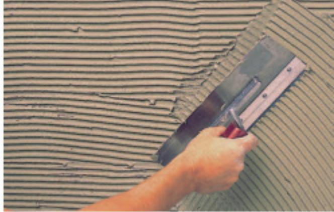
Sopro's No. 1 Flexkleber wird mit der Zahnkelle durchgekämmt. (Sopro)
