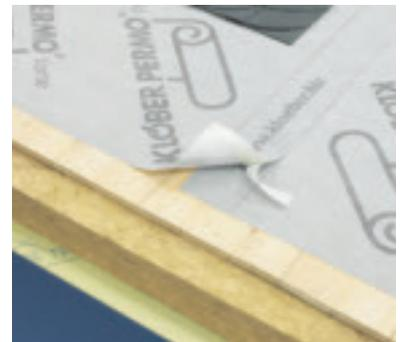
Permo® forte SK mit Selbstklebestreifen für eine jahrelang sichere Verbindung. (Klöber)
